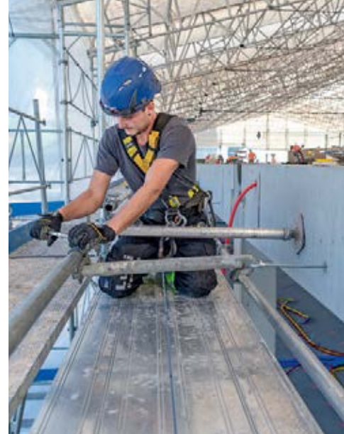
Manuel regola la distanza dell'impalcatura dalla parete.
