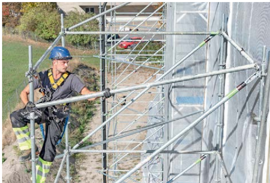
È così che si montano i ponteggi a torre, che rendono stabile l'impalcatura principale in caso di forte vento.
